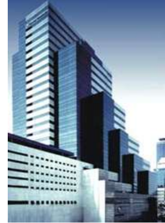
SILOM COMPLEX -E.P.-
