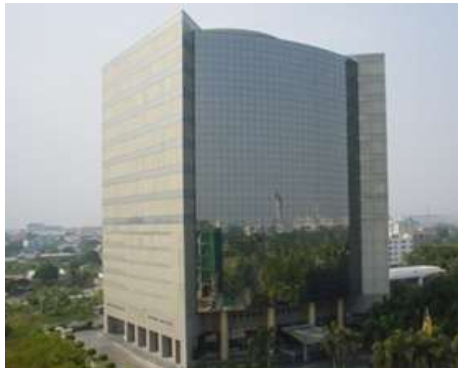
SAMAGGI TOWER - M.E.P. -
